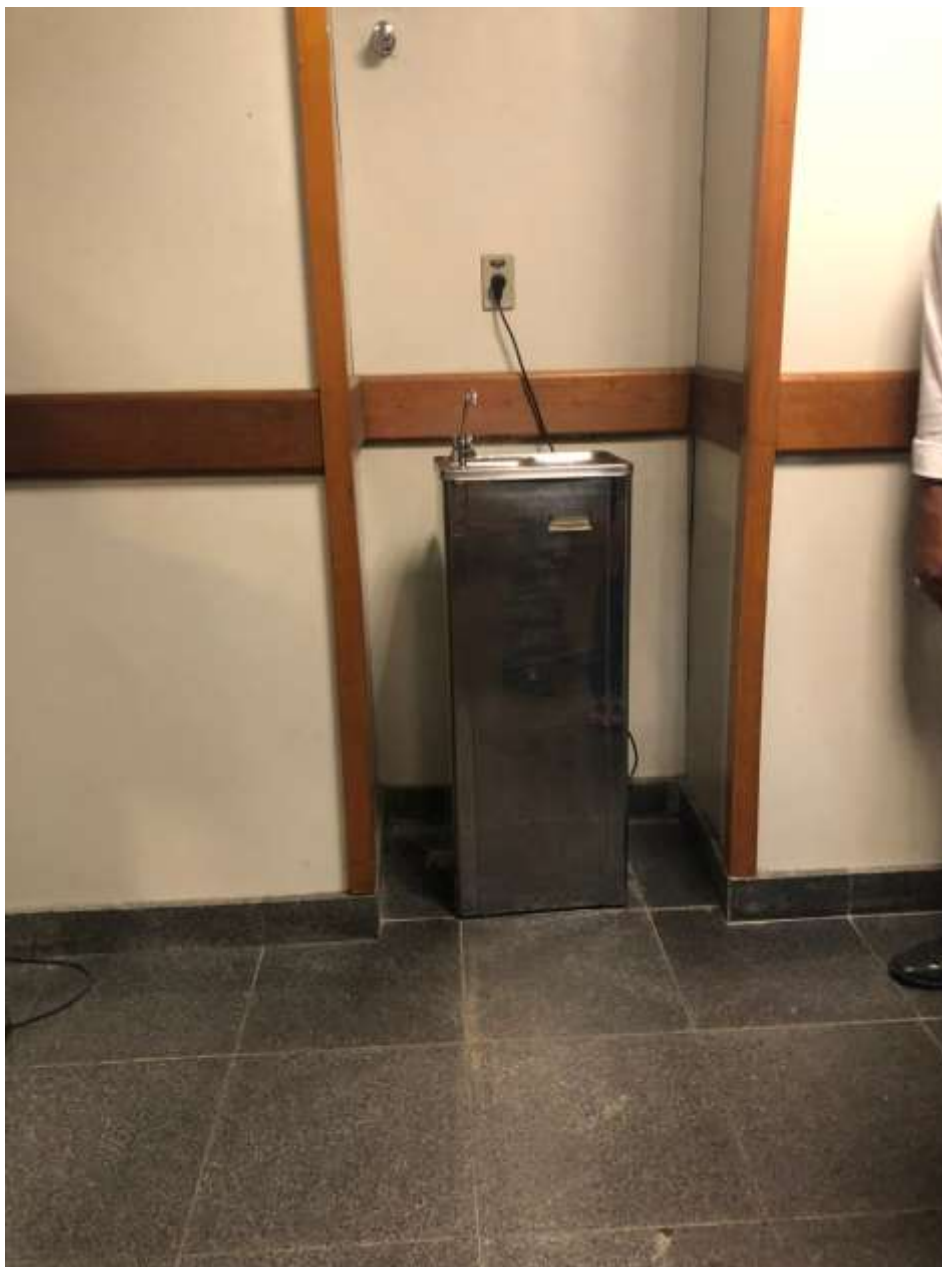
Figura 6: Bebedouros não acessíveis.
