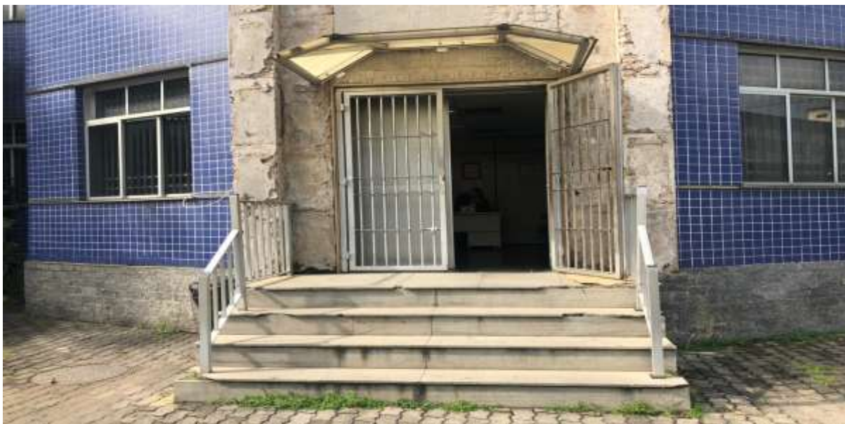
Figura 2: Prédio da Vara INFANTOJUVENIL em total desconformidade com as normas de acessibilidade, sem rampa de acesso. Data: 03/06/2019
