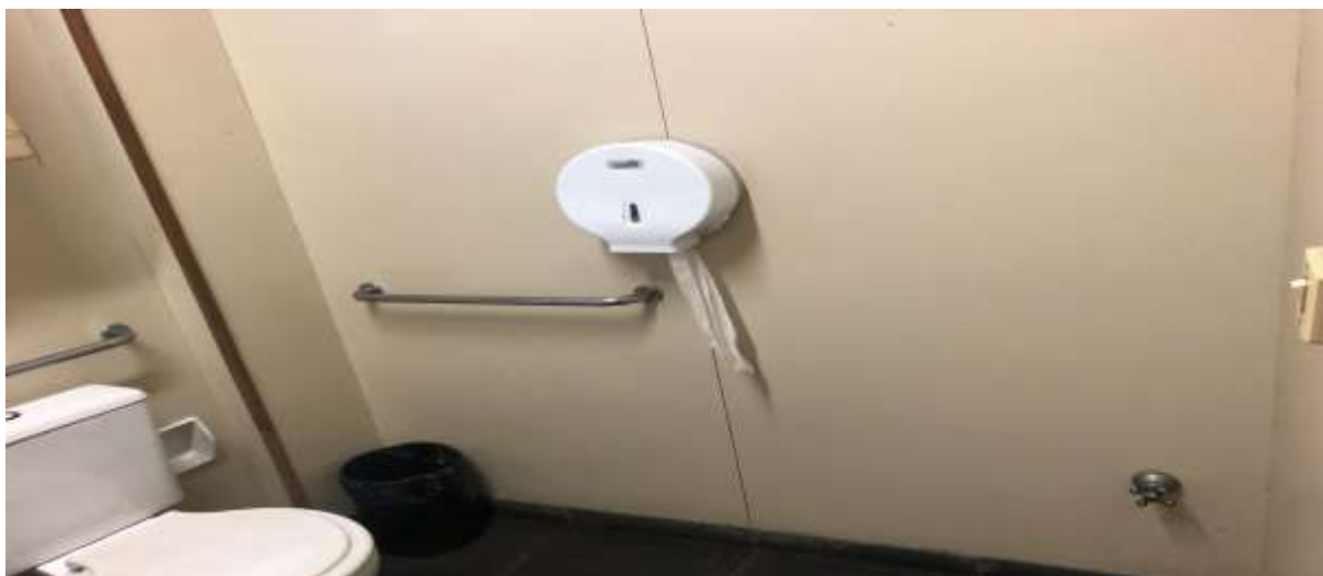
Figura 8: Banheiro acessível do prédio dos Juizados Especiais.
