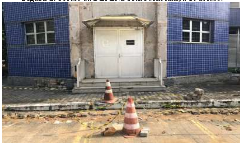
Figura 1: Prédio da DEFENSORIA sem rampa de acesso.
