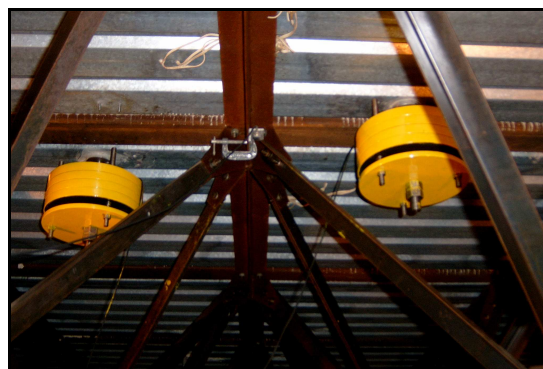
Figura 1.2 – Aplicação de ADS em protótipo de laje de piso de centros comerciais. [4].
