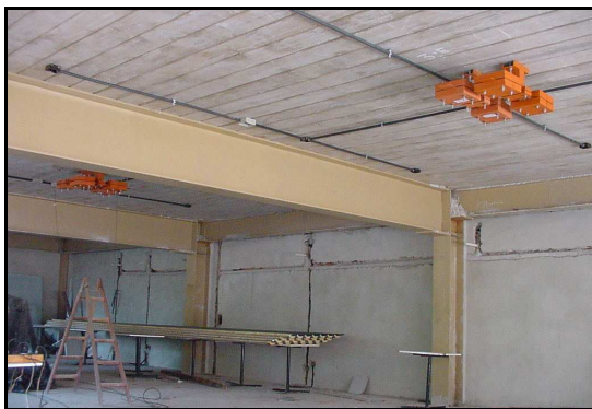
Figura 1.1 – Aplicação de ADS em lajes de pisos de edifícios [4,5].
