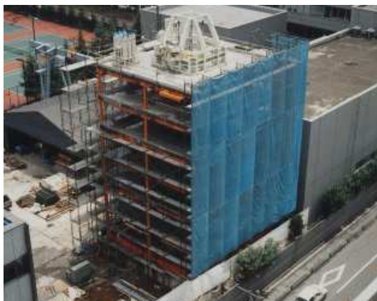
Figura 1.4 – Dispositivo de controle ativo que foi instalado em um edifício no Japão [7].
