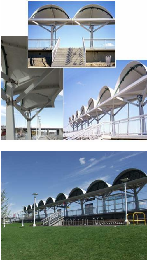
Figura 6.4 – Abrigo de pedestres em Calgary, Canadá [12]e[13]
