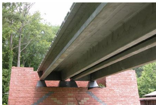
Figura 6.10 – Construção de uma ponte experimental no estado da Virgínia, EUA,[13].
