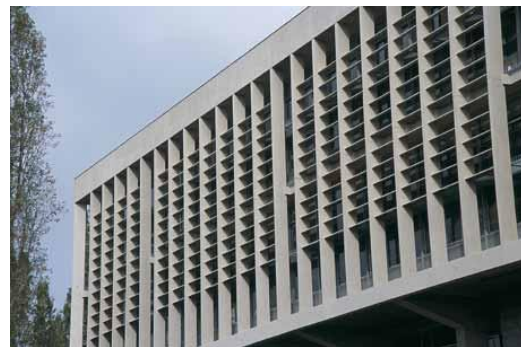
Figura 6.6 – Guarda-sóis na fachada de um edifício na Universidade de Doua, Lyon, França [13].
