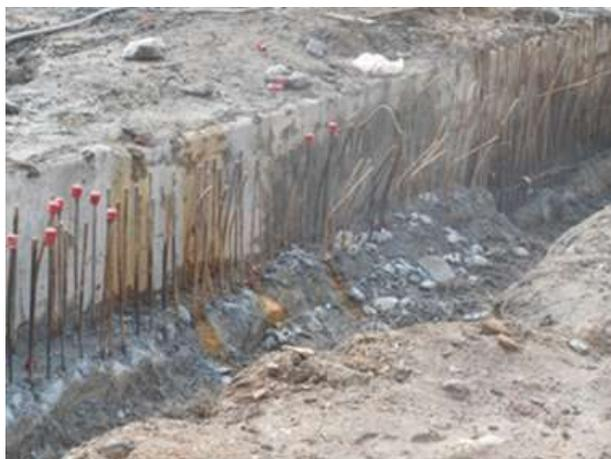
**Figura 04** - Arrasamento da viga de coroamento
