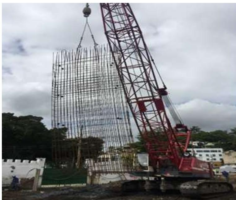
**Figura 02** - Posicionamento da Armadura
