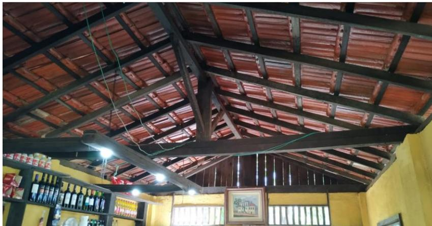
**Figura 6** - Telhado Reconstruído e tratado. Fonte: O autor (2019)
