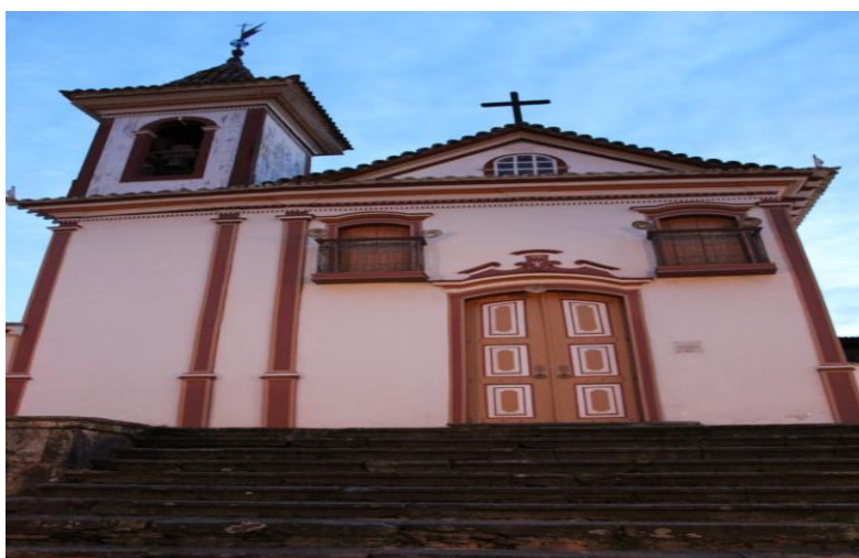
Fotografia 1: Igreja de São Francisco
