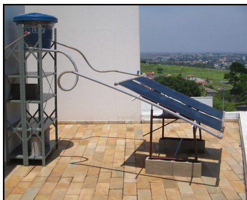
Figura 2.2 – A bancada experimental em sua forma final, destacando-se os dois coletores solares, as tubulações e o reservatório de água.
