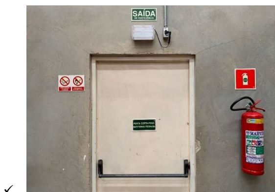
✓ Figura 10: Saída de Emergência
