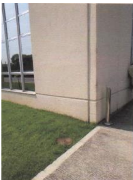
Figura 11: Caixa de inspeção
