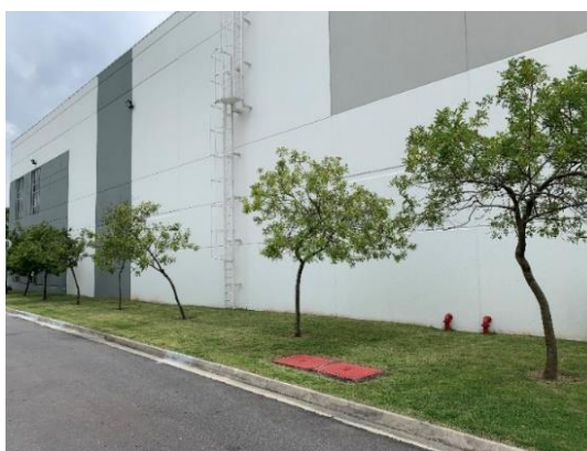
Figura 3: Hidrante de Recalque
