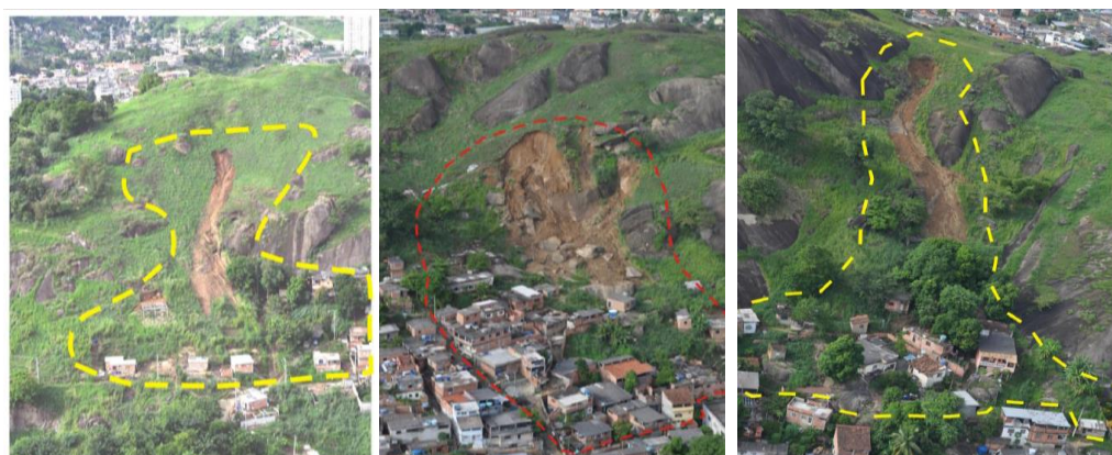
Figura 7 - Detalhamento das feições geológicas na cicatriz do deslizamento e da delimitação de área de risco iminente. Foto enviada à Defesa Civil Municipal de São Gonçalo, como delimitação das áreas de interdição imediata e urgente, em 05.05.2010. Departamento de Recursos Minerais (DRM-RJ) - Governo do Estado do Rio de Janeiro, 2010
