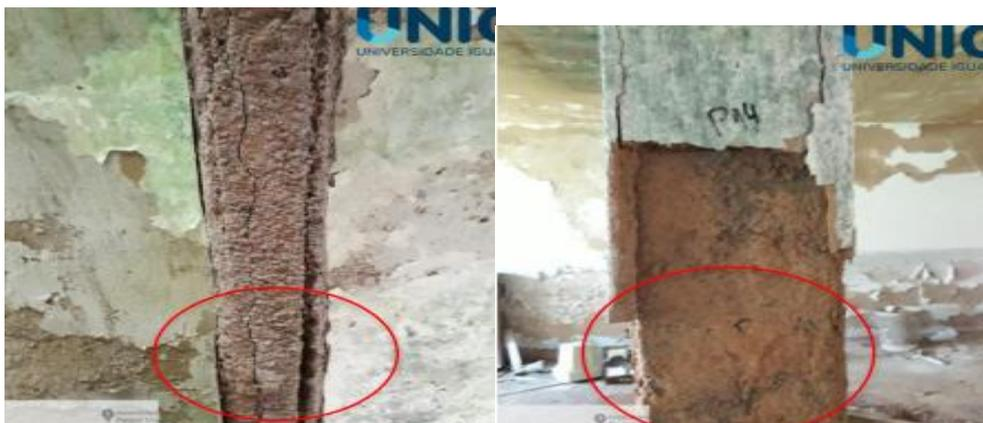
Concernente ao segundo elemento estrutural estudado (viga) constatou-se o deslocamento de seu revestimento, perda de resistência devido à falha nas armaduras, possivelmente relacionada à umidade, além de apresentar uma fissura horizontal longa e contínua em todo seu comprimento.
